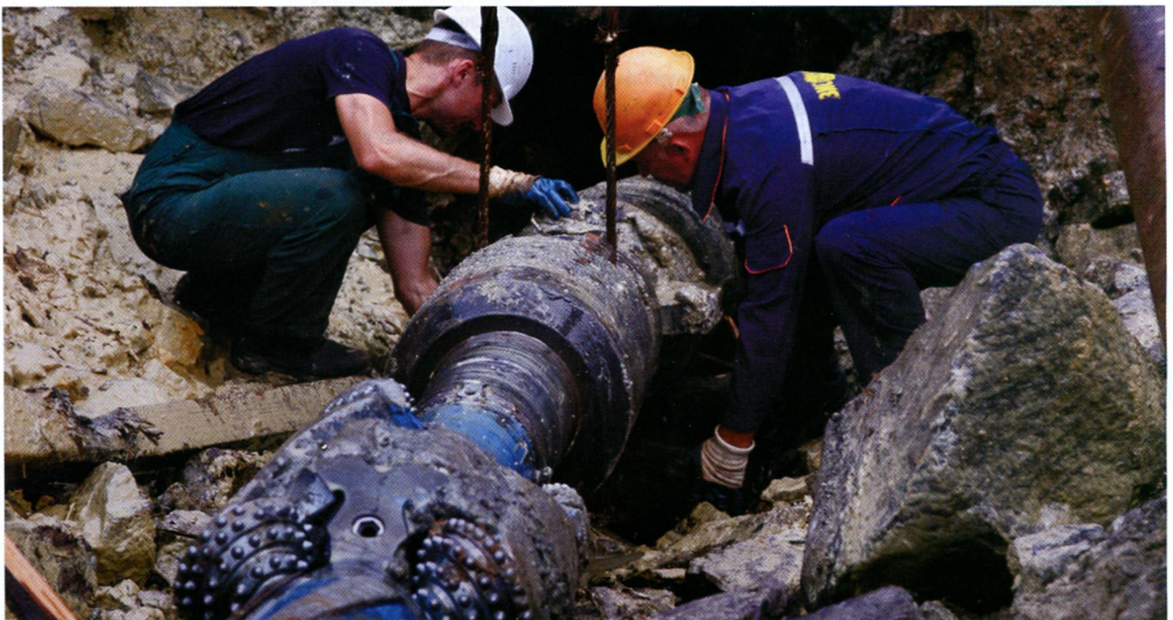
Использование бурового инструмента TRANSCO на объекте «Межпоселковый газопровод от ГПС г. Владивосток до потребителей природного газа о. Русский с отводом на ТЭЦ-2 г. Владивосток Приморского края»
