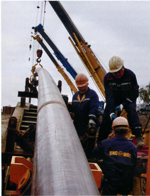
Протягивание дюкера под проливом Босфор Восточный (о. Русский)
