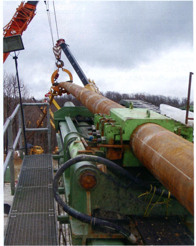
Строительство газопровода «Джубга - Лазаревское-Сочи» (морской вариант)
