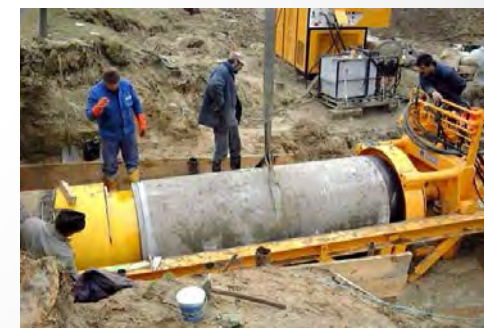
ПЕРЕХОДЫ ПОД ЖЕЛЕЗНЫМИ И АВТОДОРОГАМИ
