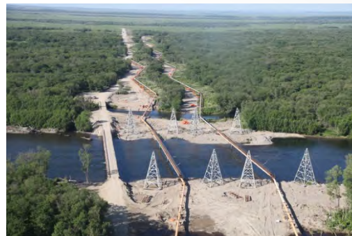
ВАНТОВЫЕ ПЕРЕХОДЫ, НАДЗЕМНАЯ ПРОКЛАДКА
