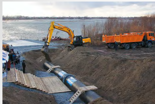
ПОДВОДНЫЕ ПЕРЕХОДЫ МЕТОДОМ ГНБ
